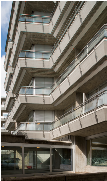
In den Betonbauten steckt viel graue Energie. Bild: Baugeschichtliches Archiv, Juliet Haller (2016)
